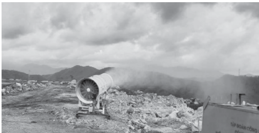
Hình 1. Hệ thống phun sương dập bụi bãi thải Bàng Nâu – Công ty than Cao Sơn [2]
