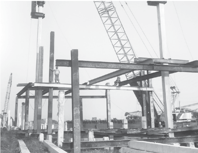
Hình 1. Quả búa nằm trong khung giá khi đóng cọc
