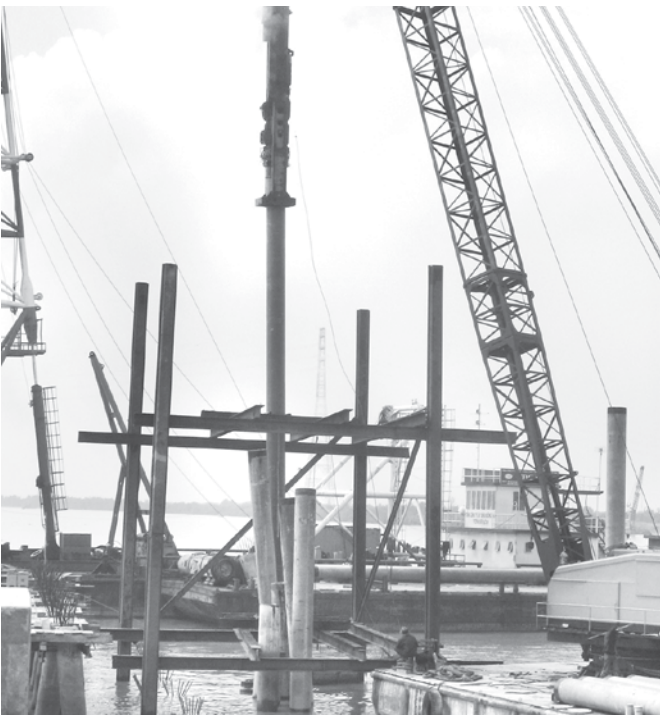
Hình 4. Thi công cọc trên mặt nước bằng búa treo
