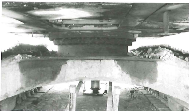
Thí nghiệm bàn nén- Sử dụng máy xúc
