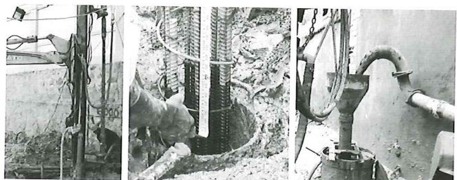
Hình 6. Hạ lồng thép và đổ bê tông cọc
