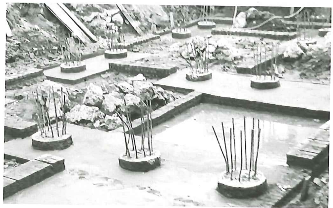
Hình 5. Cọc khoan nhồi đường kính nhỏ
