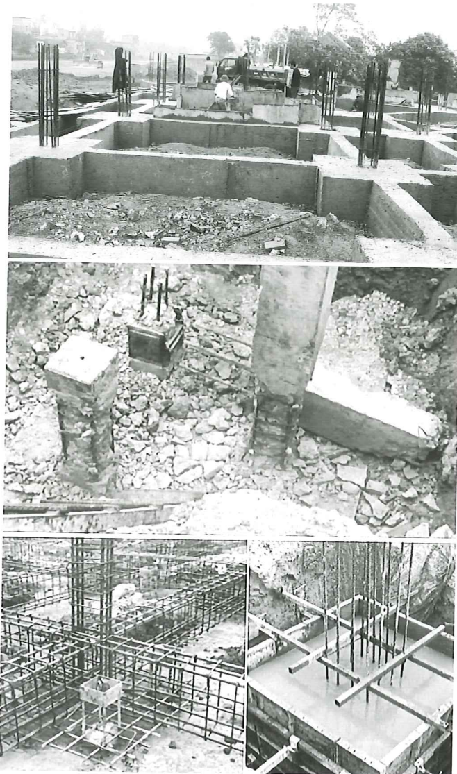
Hình 3. Móng cọc ép
