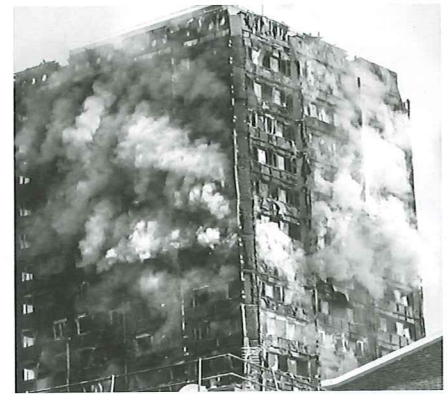
Hình 3. Cháy tại chung cư Grenfell 24 tầng ở London (Vương Quốc Anh)
