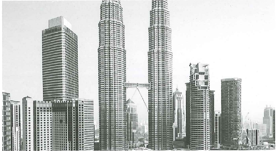
Phải quan tâm đến việc xây dựng các biện pháp đặc biệt để đảm bảo an toàn phòng cháy chữa cháy của các tòa nhà cao tầng
