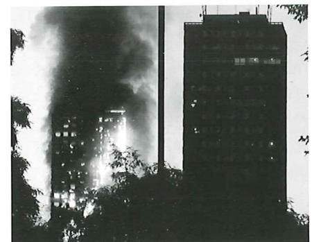
Hình 4. Chung cư Carina Plaza bốc cháy trong đêm
