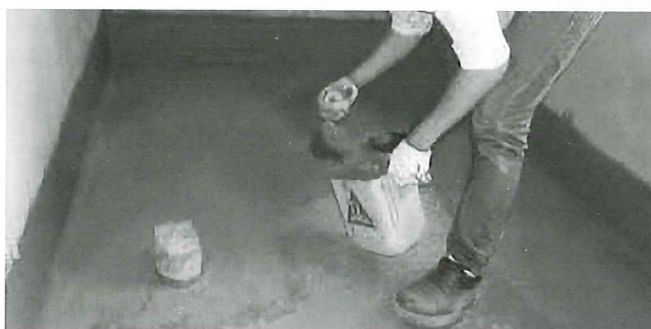
Hình 8. Quét sika lên bề mặt cần chống thấm
