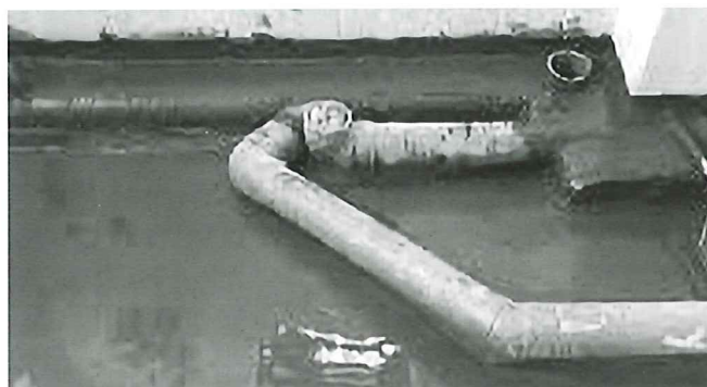
Hình 3. Sơn gốc polyurethane 2 thành phần
