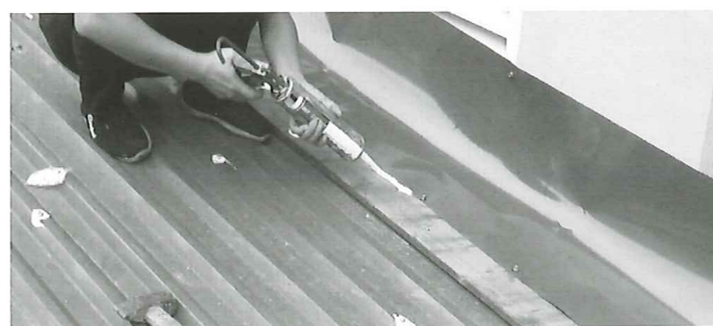
Hình 6. Bắn keo gốc silicon và keo tạo màng gốc polymer, acrylic
