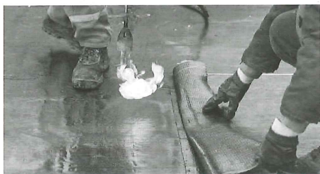
Hình 1. Khò chống thấm-nóng
