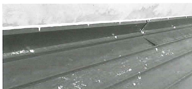
Hình 5. Bơm keo poly urethane đàn hồi để trám kín khe hở giữa tôn ghép và tường
