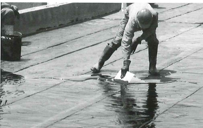
Hình 10. Quét bitum bằng bàn phẳng
