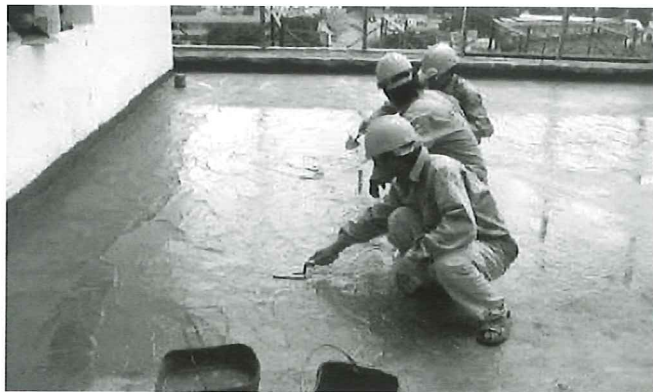
Hình 7: Cán vữa chống thấm
