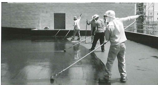
Hình 9: Lăn bitum bằng con lô
