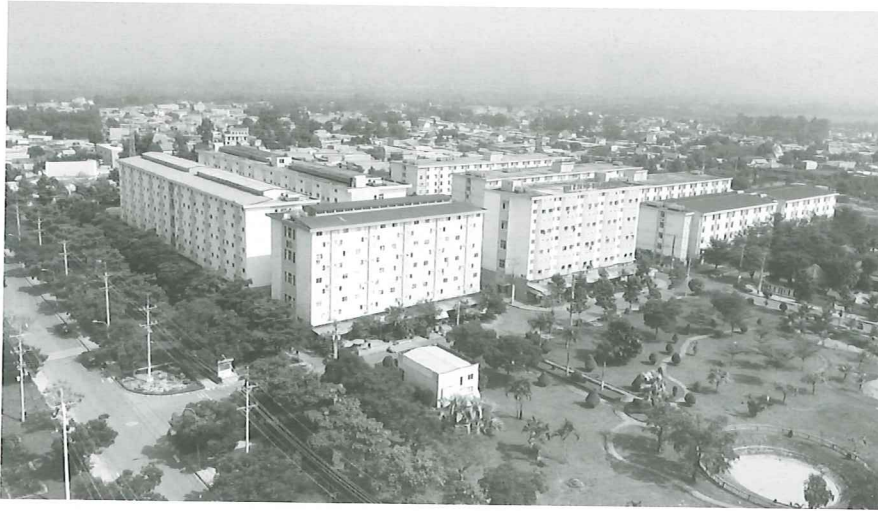
Dự án nhà ở xã hội khu công nhân Nhơn Trạch, Đồng Nai
