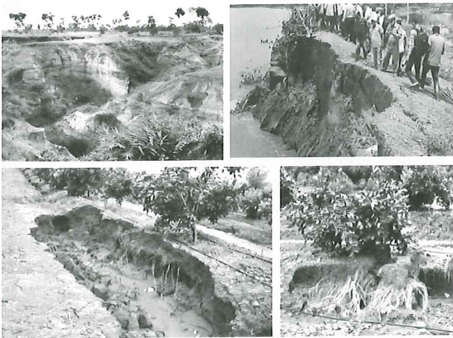
Hình 2. Xói mòn do thoái hoá đất nền
