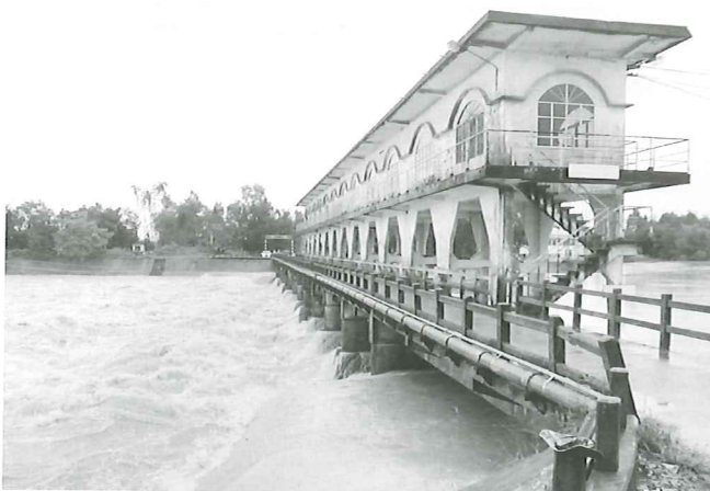
Cần quản lý và vận hành đập An Trạch hợp lý hơn nhằm nâng cao hiệu quả sử dụng đập
