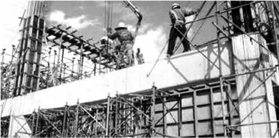
Hiện nay, an toàn lao động khi thi công công trình nhà cao tầng luôn là vấn đề nhức nhối đối với tất cả các dự án
