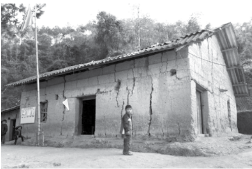
Hình 3. Nhà trình tường người Mông ở huyện Xín Mần, tỉnh Hà Giang
