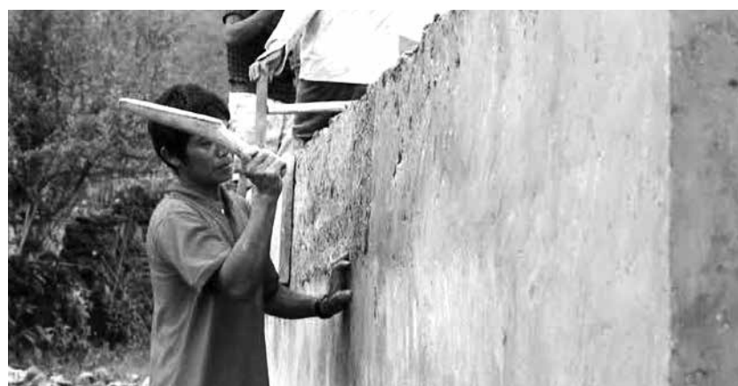
Hình 4. Kỹ thuật trình tường (nện đất thành tường) và hoàn thiện bề mặt
