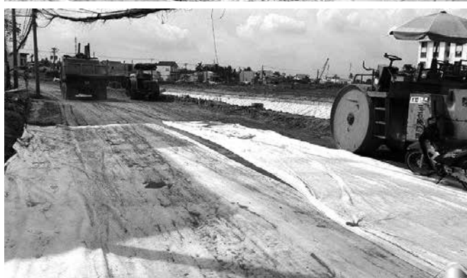
Sử dụng giải pháp cọc bê tông kết hợp với vải địa kỹ thuật giúp thi công dễ dàng và gia cố chắc chắn cho nền móng xây dựng
