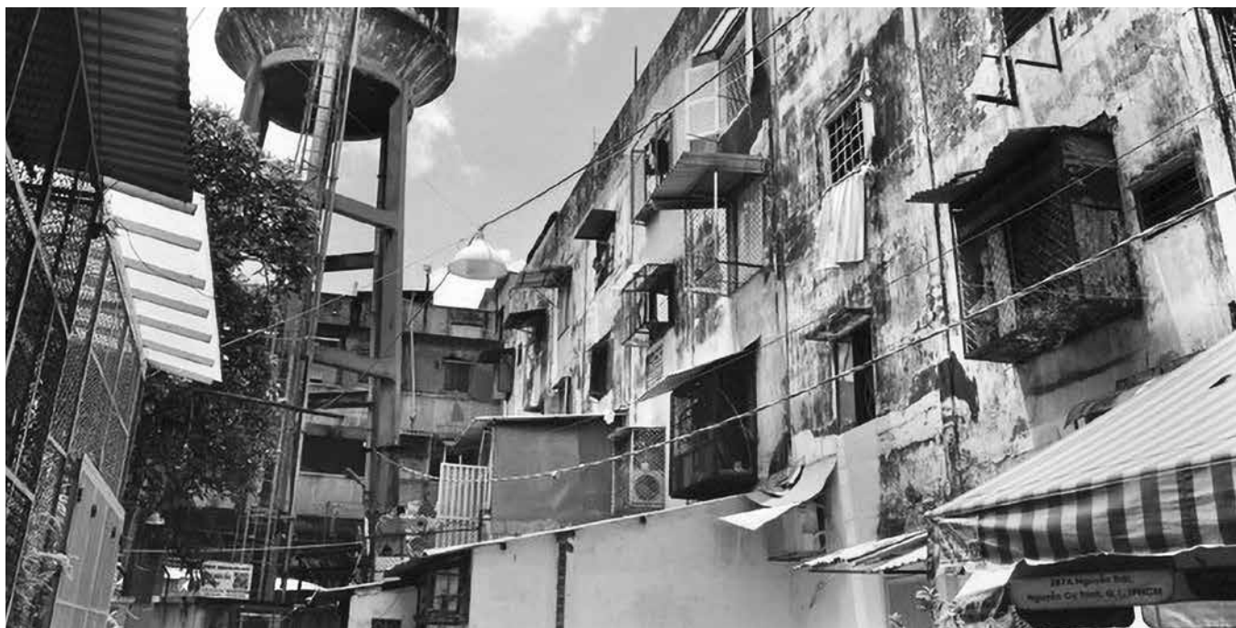
Rất nhiều chung cư được xây dựng từ năm 1975 - 2005 đều không có hệ thống phòng cháy chữa cháy
