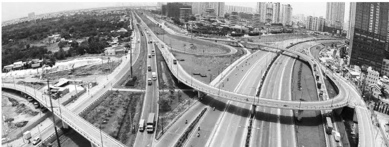
Tập trung nguồn lực đầu tư xây dựng hoàn chỉnh hệ thống kết cấu hạ tầng kinh tế và kỹ thuật diện rộng, hạ tầng số
