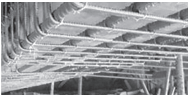
Hình 6. Gia cố dầm BTCT bị ăn mòn
