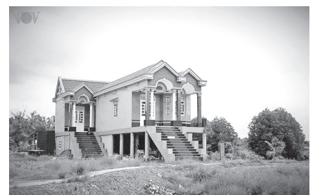
Hình 6. Nhà xây kiểu tầng rỗng (cao cẳng) trên nền đất trũng thấp ở Cà Mau
