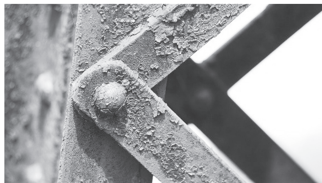
Hình 5. Hình ảnh minh họa sự ăn mòn của vật liệu
