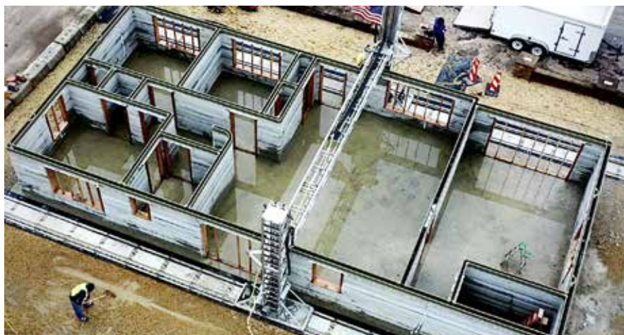
In 3D trong xây dựng là công nghệ tiên tiến, cho phép tạo ra các chi tiết và cấu kiện xây dựng một cách nhanh chóng, chính xác
