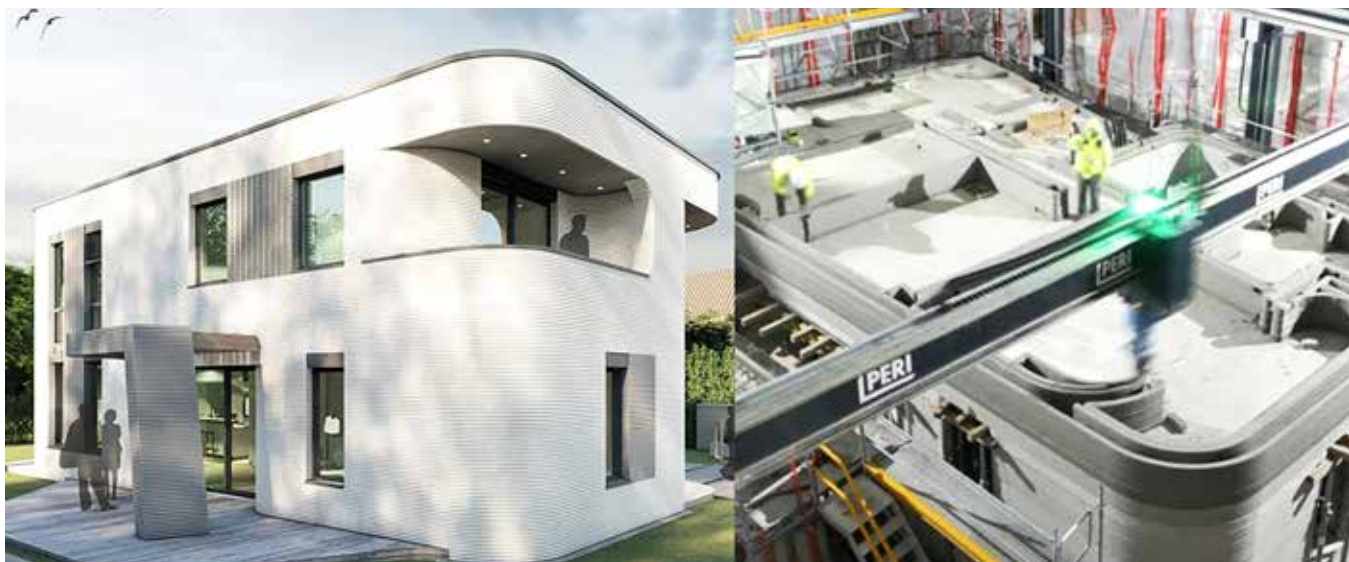
Với in 3D, các hạng mục công trình có thể được chế tạo đồng thời, cho phép hoàn thành dự án nhanh hơn
