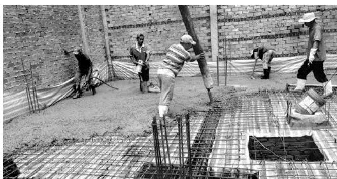
Hình 1: Kết cấu nền bê tông cốt thép toàn khối
