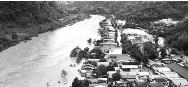
Hình 4. Đợt mưa lũ tháng 9/2024, Cao Bằng có 663 ngôi nhà bị thiệt hại
