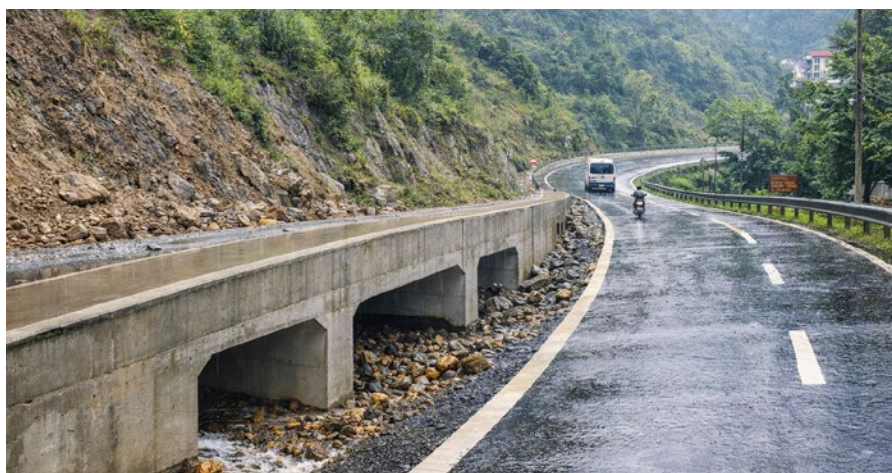
Hình 3. Giải pháp nâng chuẩn thiết kế thoát nước và cổng ngang nhằm thích ứng với mưa cường suất cao
