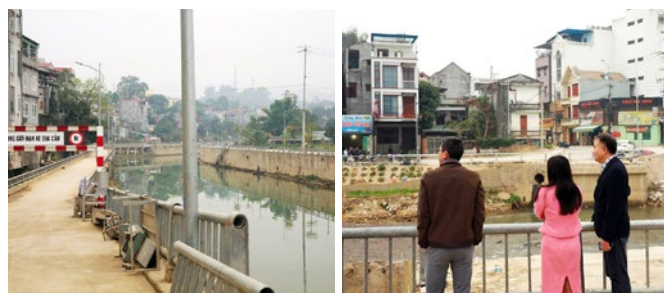
Hình 2. Điểm ngập sâu cầu Hòa Chung - phường Thực Phán > 3m (10/2025)
