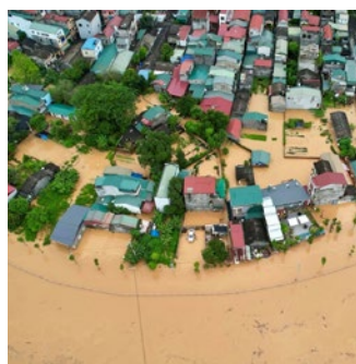
Hình 4. Ngập lụt trong đô thị miền núi, rủi ro tổng hợp giữa mưa tại chỗ và lũ trên lưu vực
