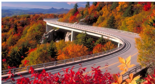
Hình 8. Cầu cạn ngắn tại đoạn địa hình miền núi đặc biệt khó khăn
