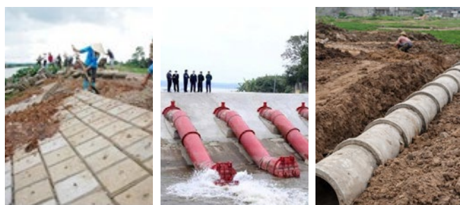
Hình 3a,b,c. Hệ thống Kè bờ sông - Trạm bơm Hệ thống cống thoát nước
